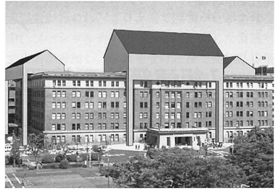
改修時の鉄骨素屋根イメージ
