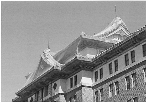
西側屋根銅板の落下防止措置
