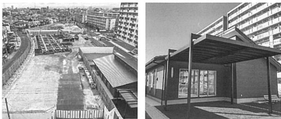
D棟・F棟 工事現場
