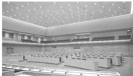
愛知県議会議場 膜天井施工後
