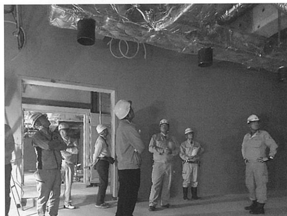
2階の収蔵庫頭上の配管
