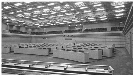
愛知県議会議場 仮設吊足場の設置状況
