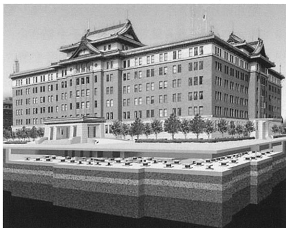
基礎免震装置の設置イメージ
