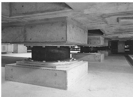
免震装置設置状況（積層ゴムアイソレータ）
