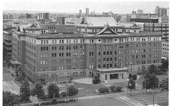
現在の愛知県庁本庁舎
