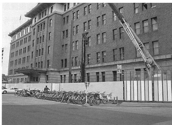
耐震改修工事の様子（山留親杭施工状況）
