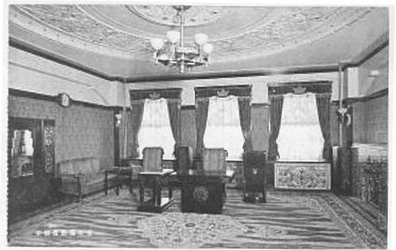
竣工当時の貴賓室
