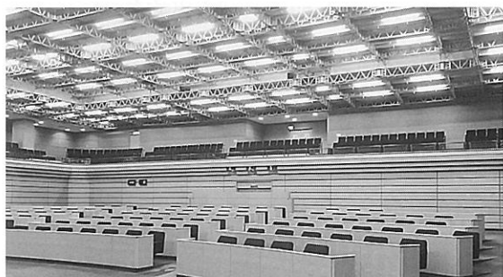
【吊り足場設置後の議場内部】
