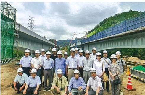
(新東名高速道路の工事現場にて)
