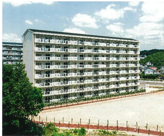
原山台住宅建築工事（第8工区）
