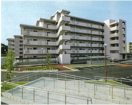
小島住宅建築工事（第2工区）
