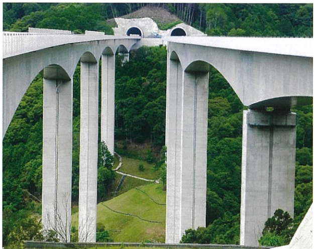
(国内で4番目に橋脚が長い佐奈川橋)
