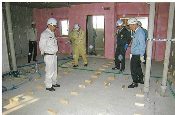
平成 28 年 11 月 17 日 初吹住宅工事見学会
