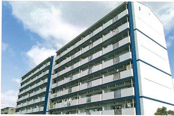
清水住宅建築工事
