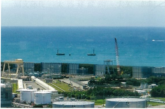
(浜岡原子力発電所の防波壁建設現場)
