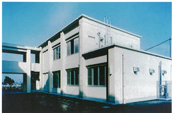
県立海翔高校校舎等建設工事
