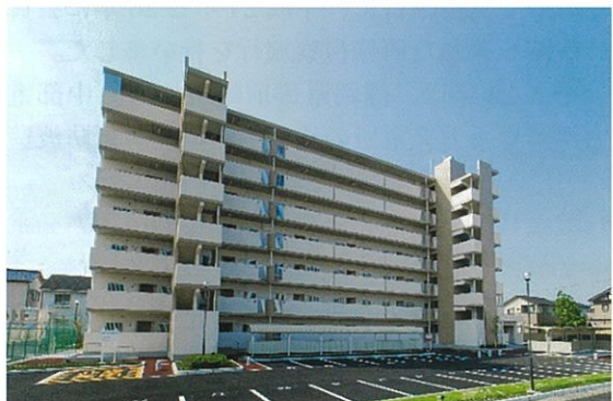
愛宕住宅建築工事 (第2工区)
