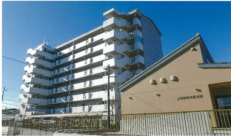
上和田住宅建築工事（第1工区）
