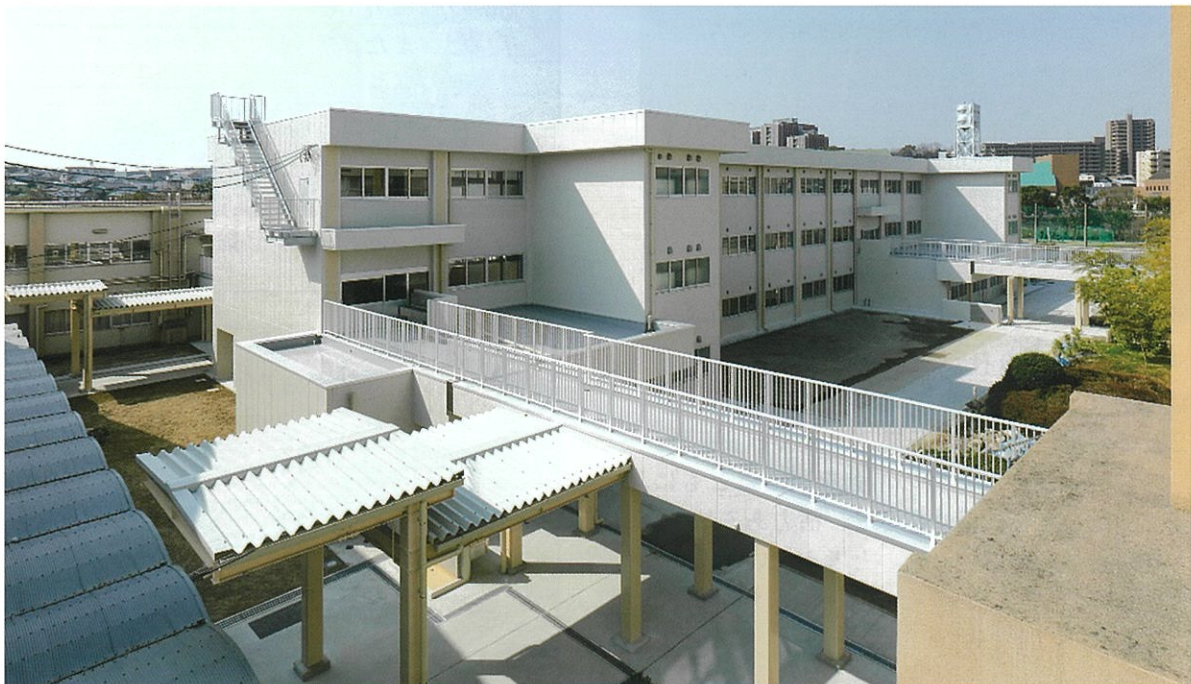
岡崎商業高等学校校舎建築工事
