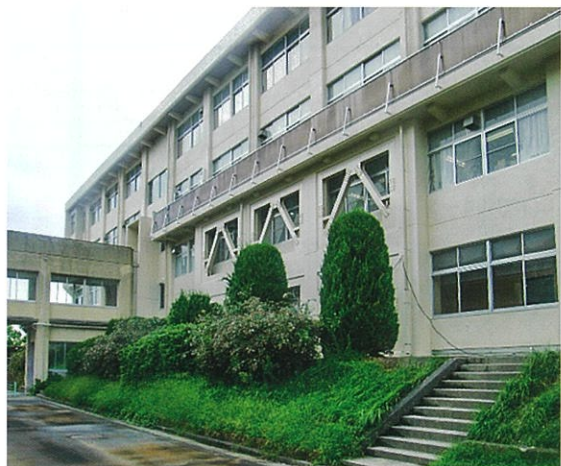
高蔵寺高校改修工事
