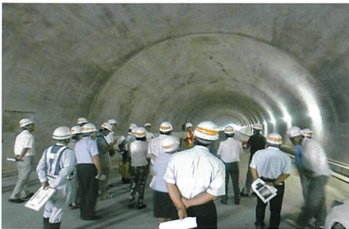
(新東名のトンネル内現場)
