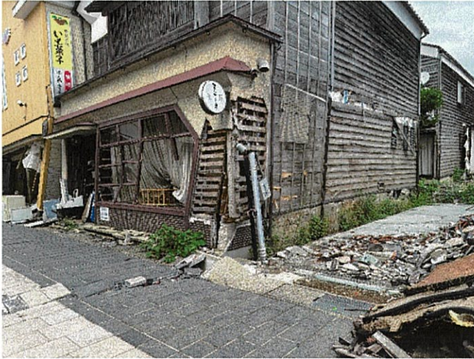
朝市通り被害建物
