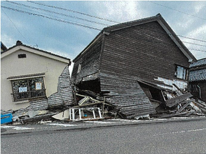
1階部分が地震により倒壊
