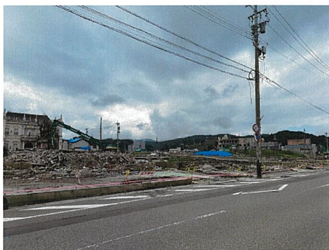
輪島朝市 焼失建物解体状況
