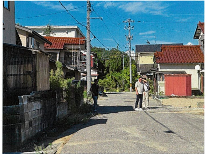
RC 造車庫沈下
