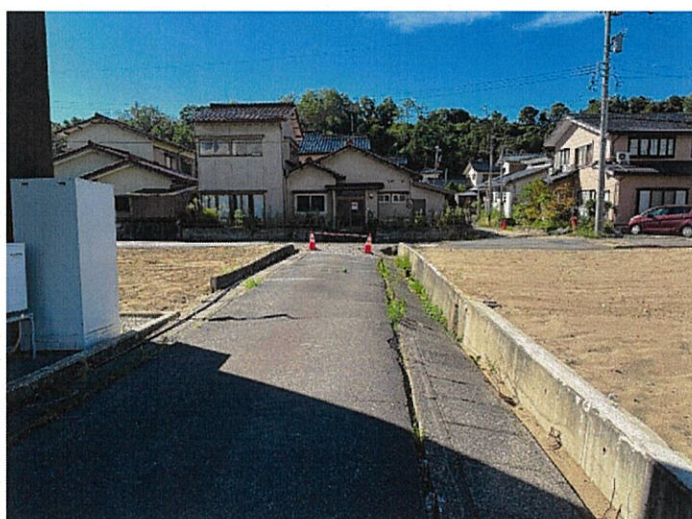
側溝・道路が傾斜
