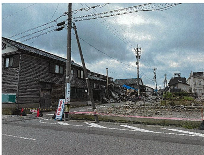
輪島朝市 焼失建物解体状況
