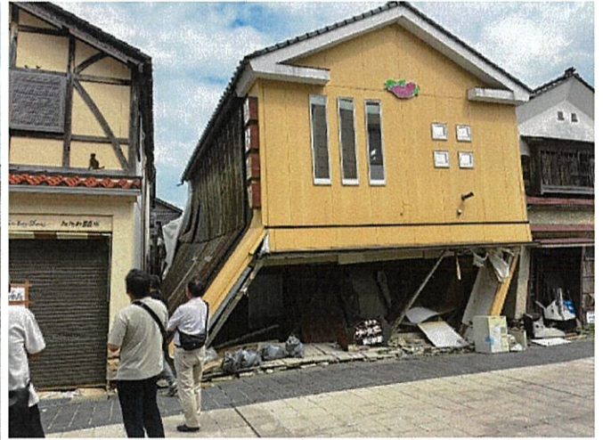
1階部分が地震により倒壊
